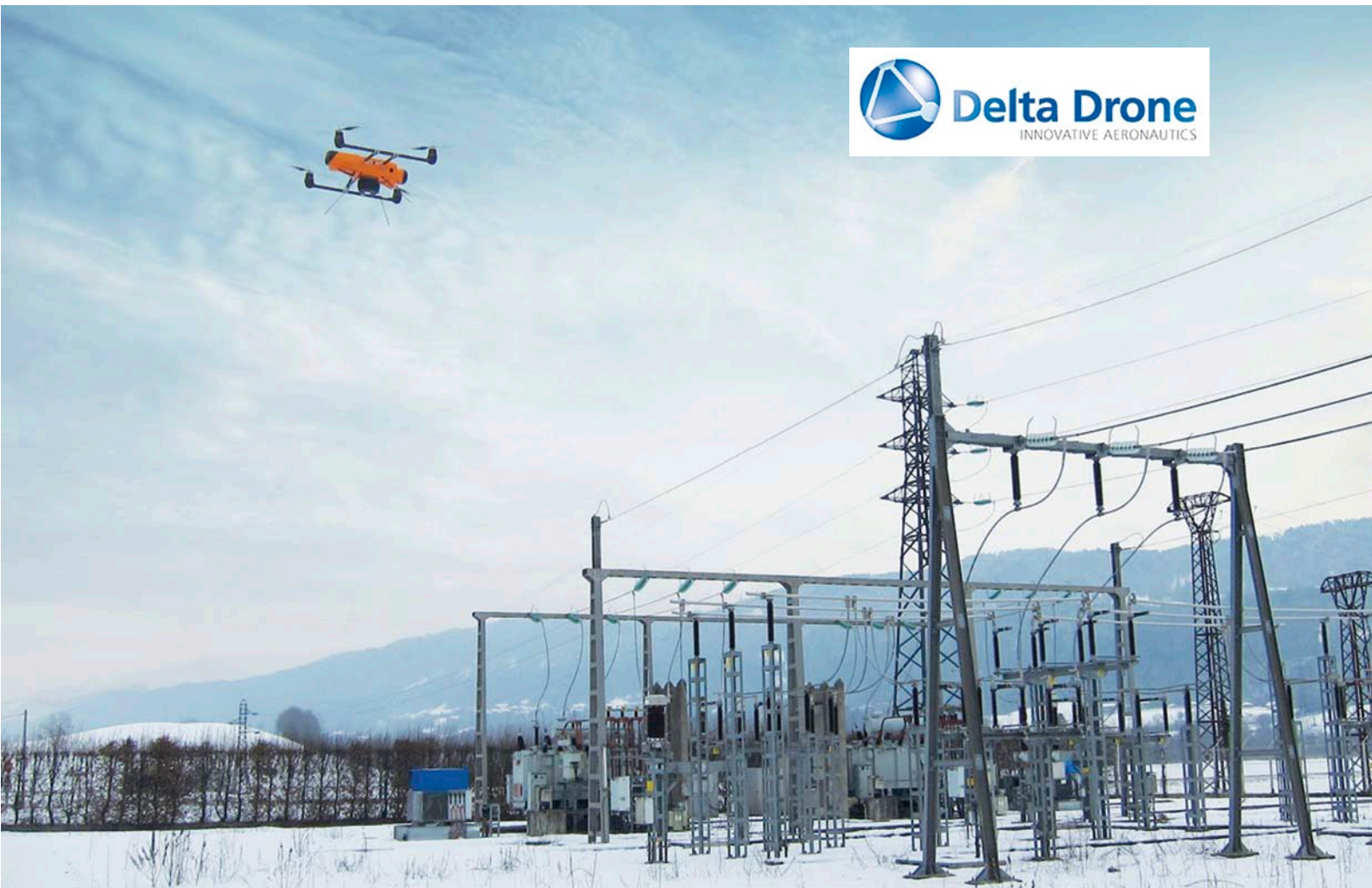
Système Drone 2.0° inspectant un poste de transformation électrique © Delta Drone
